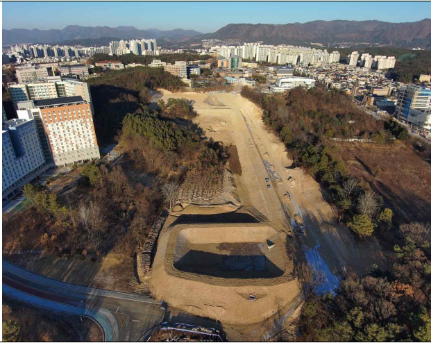
도시첨단산업단지 조성 공사 현장
