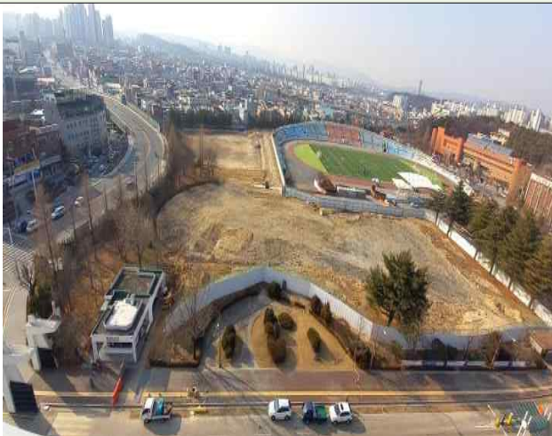
도시첨단산업단지 조성 공사 현장
